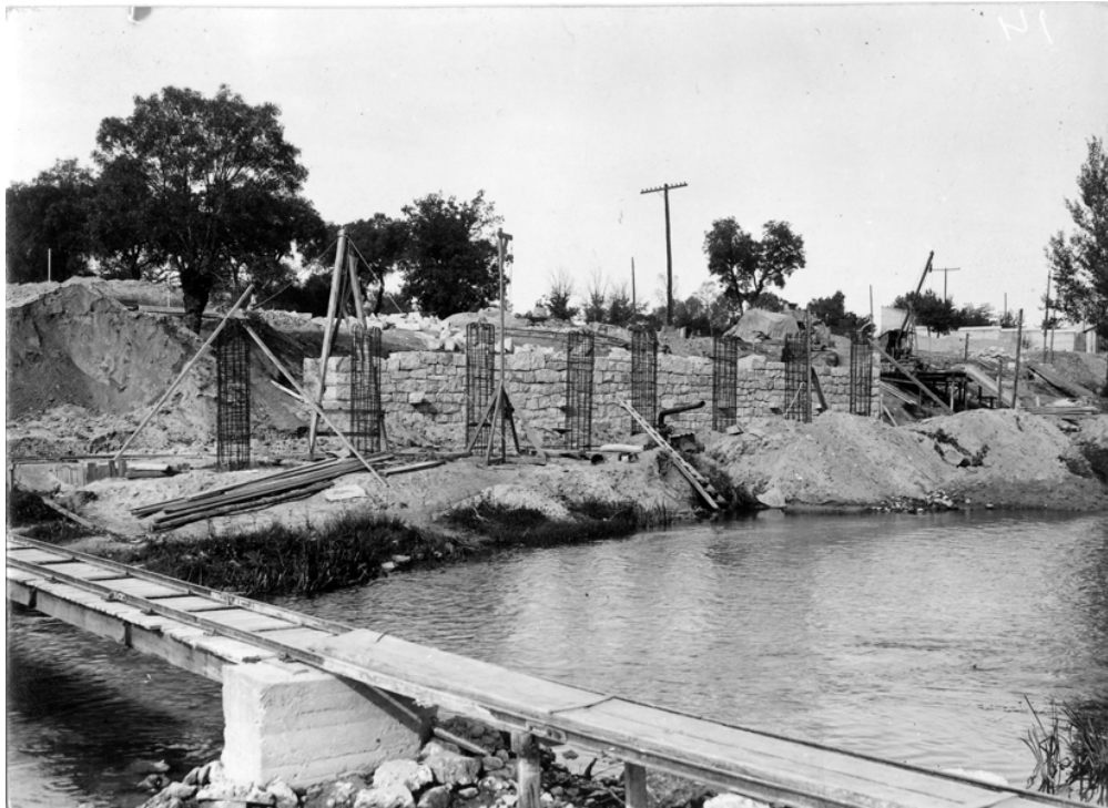
Vista del puente en construcción
