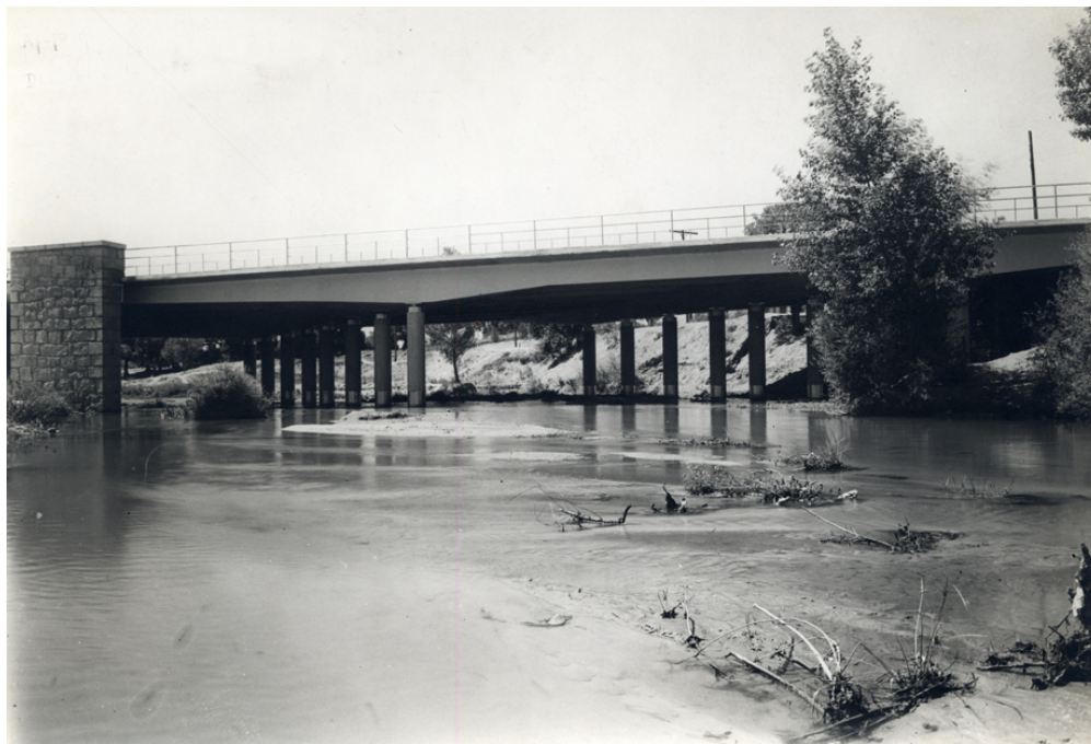
Vista del puente
