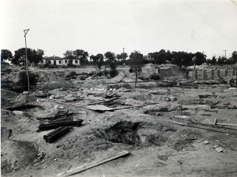
Vista del puente en construcción
