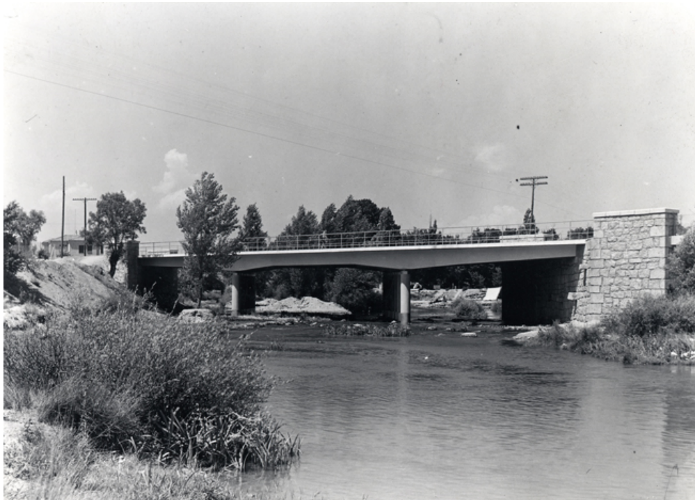
Vista del puente
