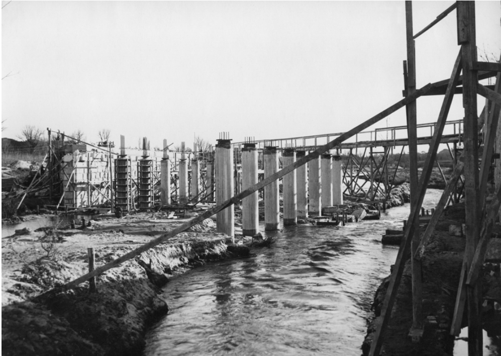
Vista del puente en construcción
