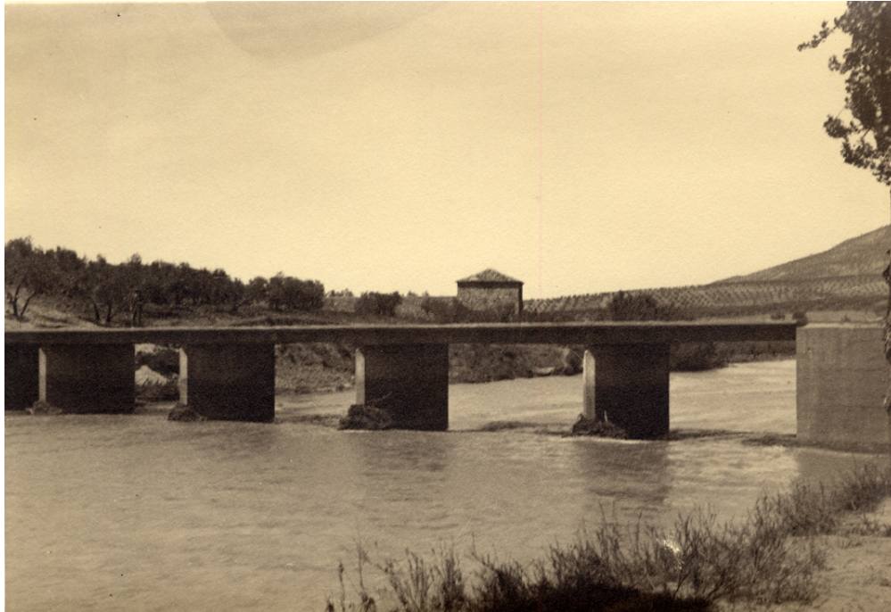
Vista del puente
