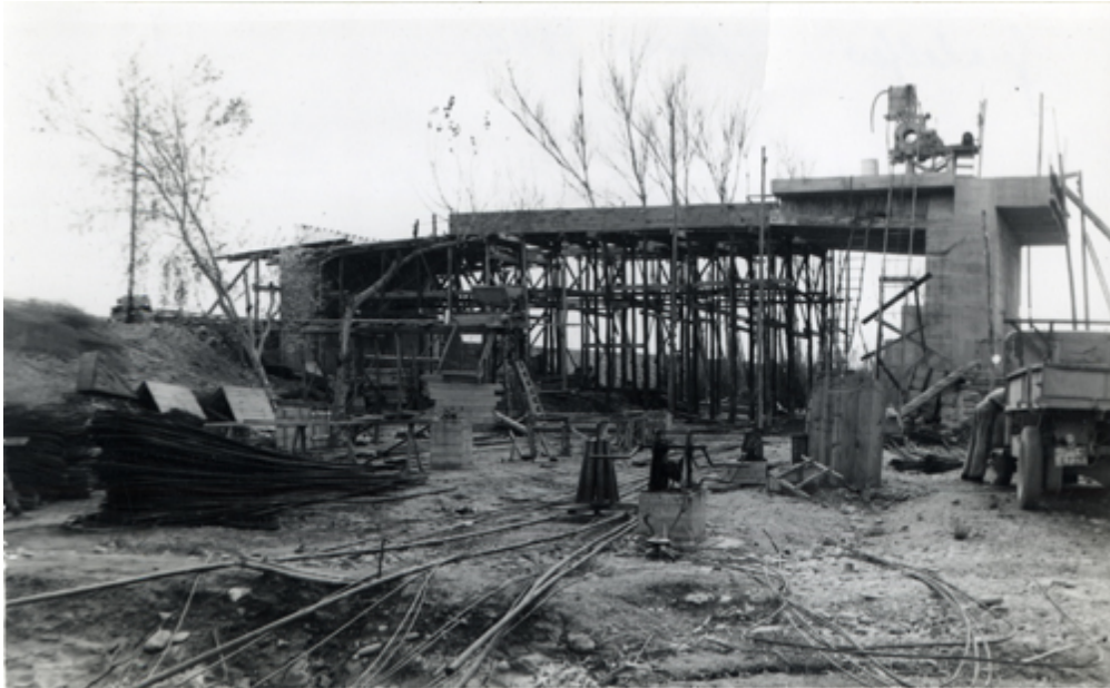
Vista del puente en construcción
