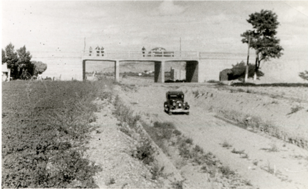
Vista general del puente con vehículos
