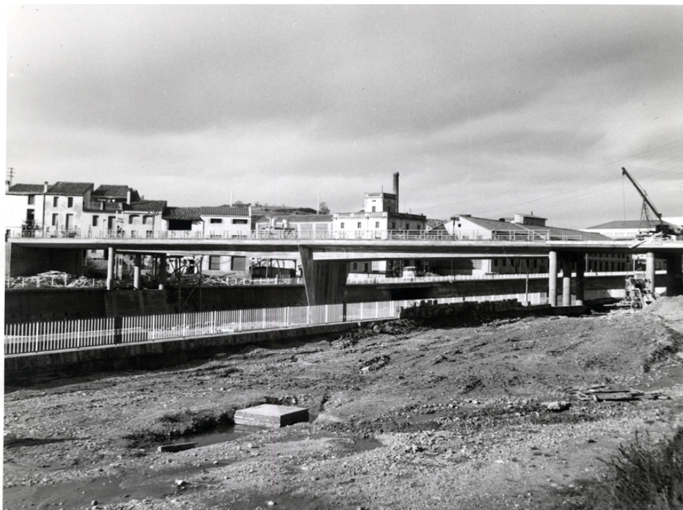
Vista general del puente "A"
