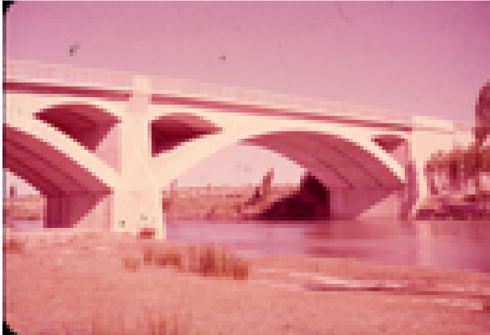
Vista del puente
