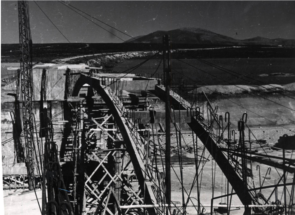
Detalle del arco en construcción
