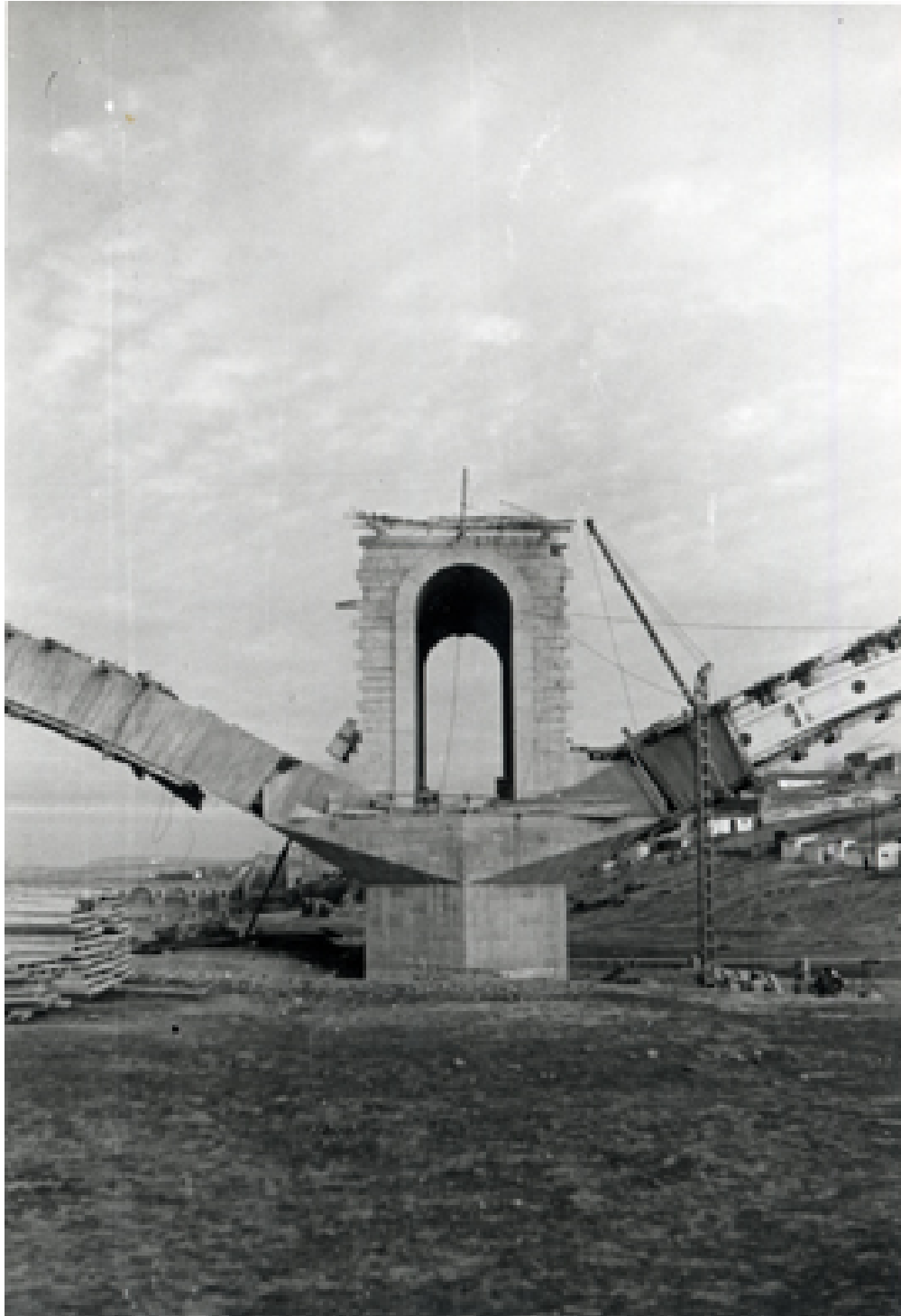
Detalle del puente en construcción
