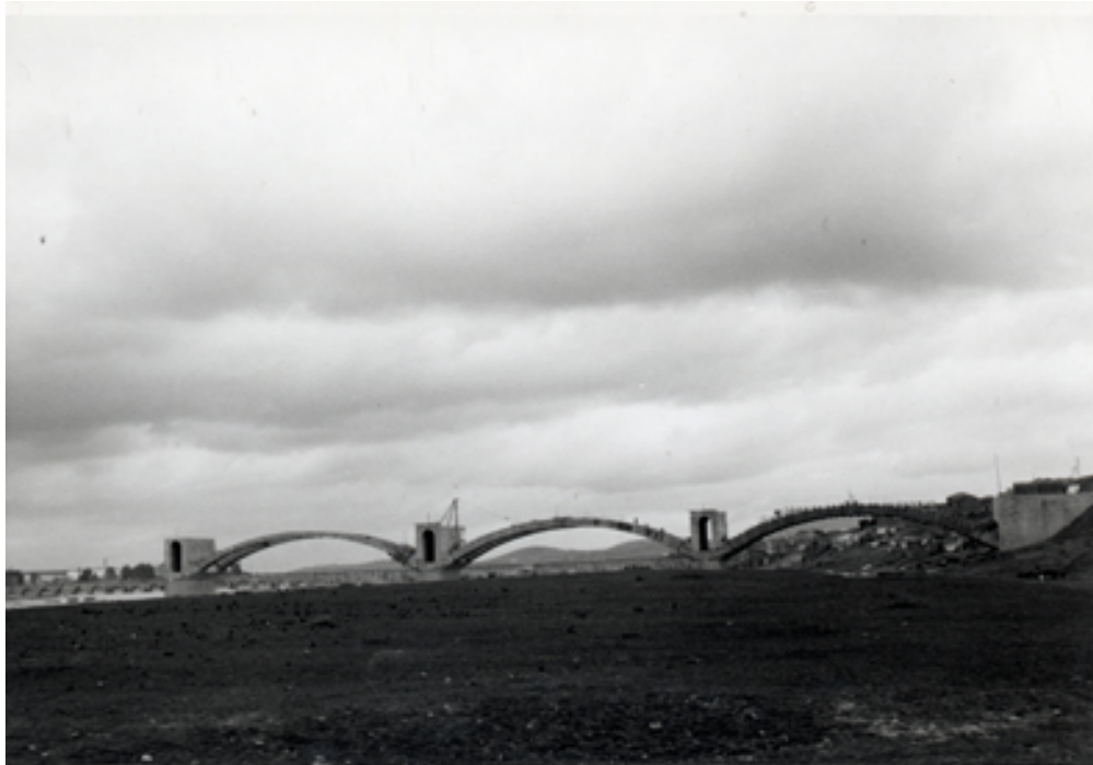
Vista del puente en construcción
