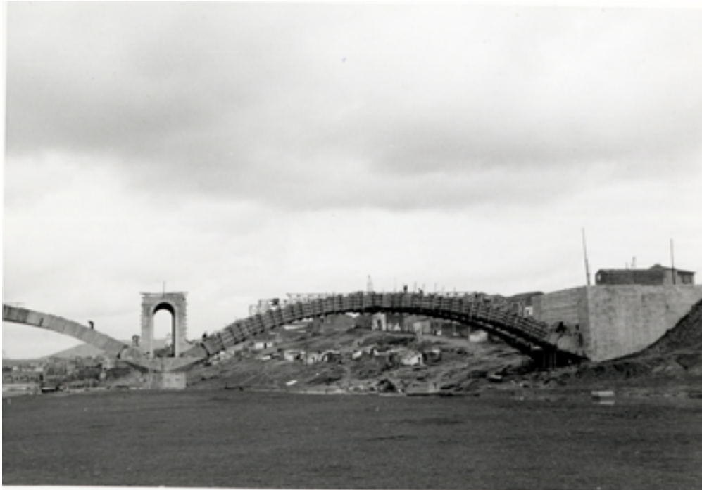
Vista del puente en construcción
