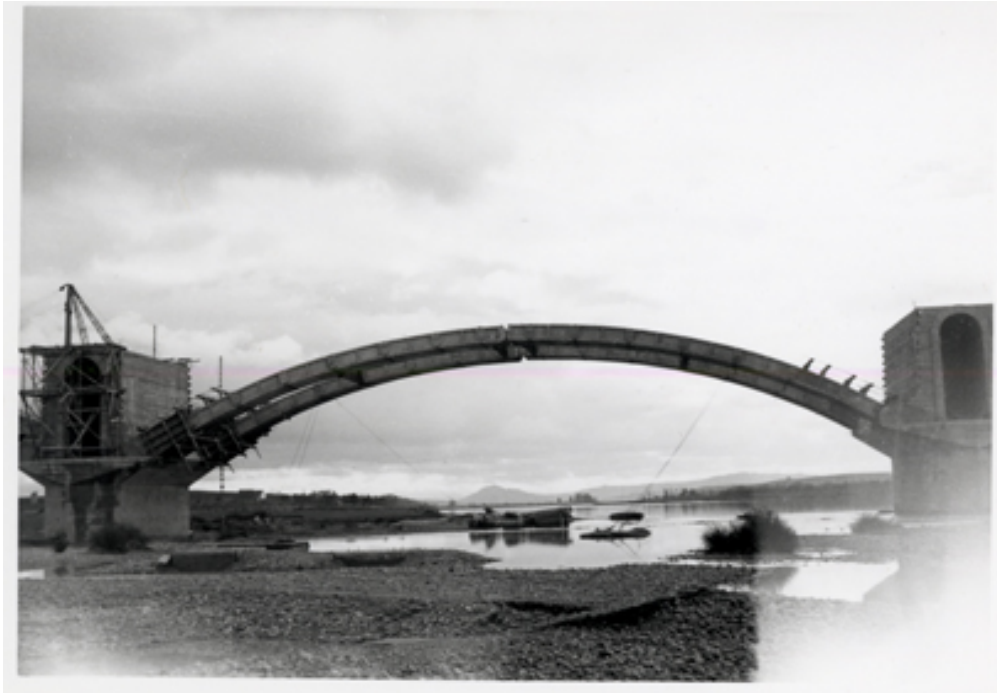
Vista del puente en construcción
