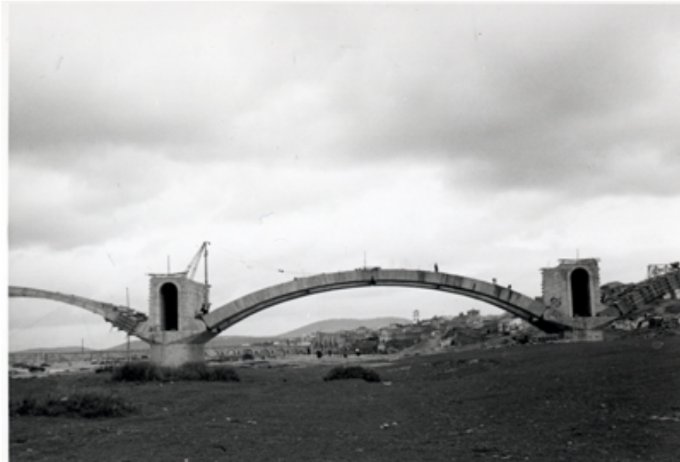
Vista del puente en construcción
