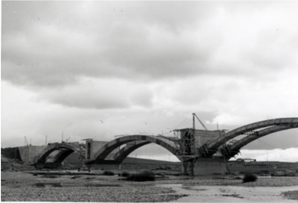
Vista del puente en construcción
