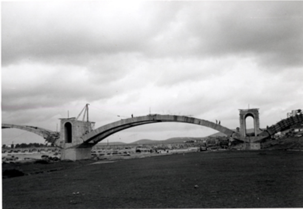
Vista del puente en construcción
