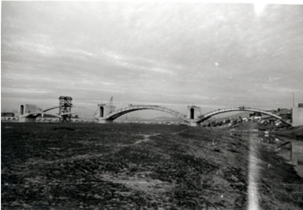
Vista del puente en construcción
