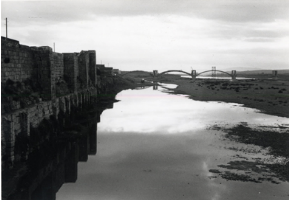
Vista del puente en construcción
