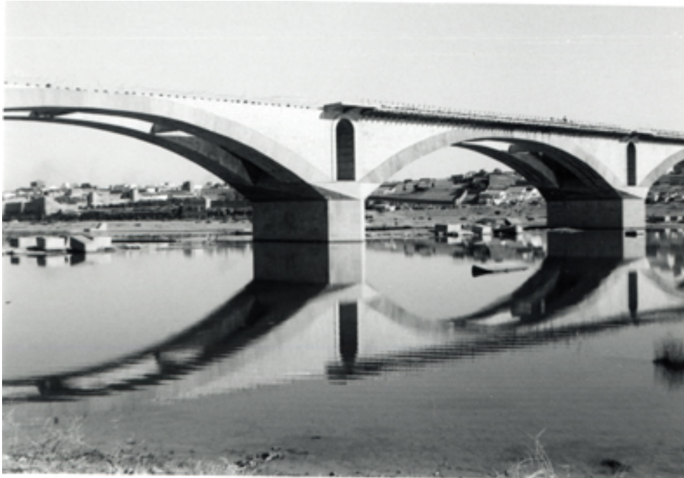
Detalle del puente en construcción
