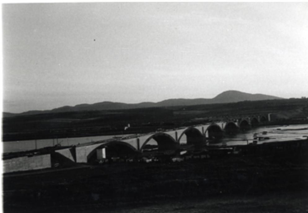
Vista del puente
