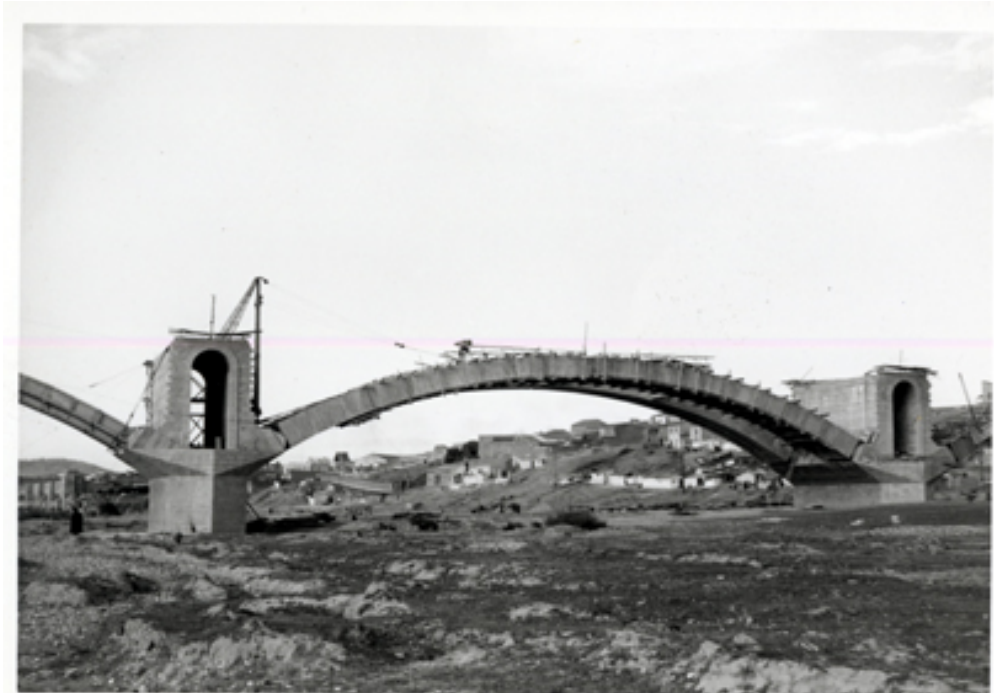
Detalle del puente en construcción
