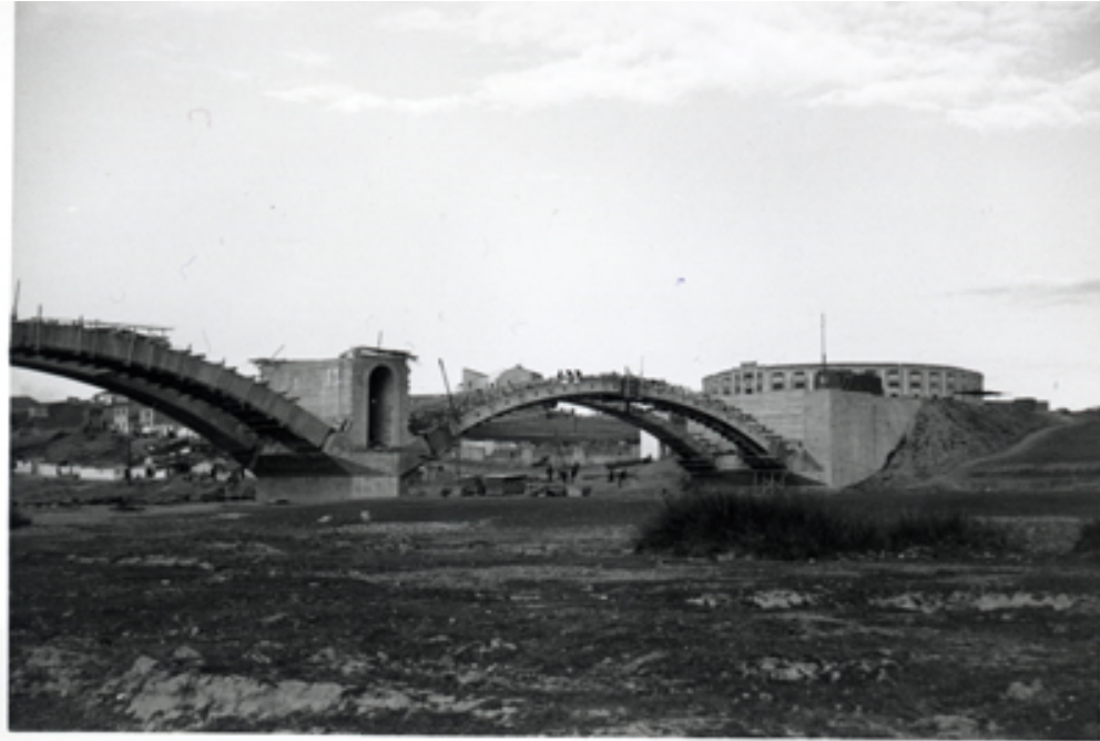
Detalle del puente en construcción
