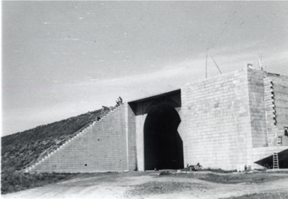
Detalle del puente en construcción
