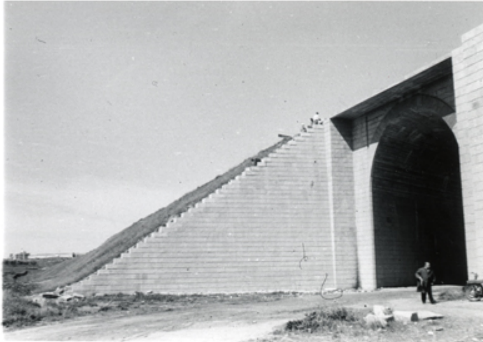
Detalle del puente en construcción
