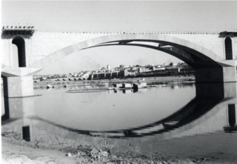
Detalle del puente en construcción
