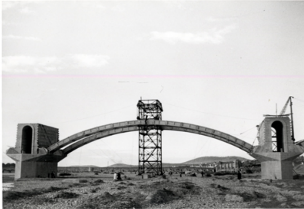
Detalle del puente en construcción
