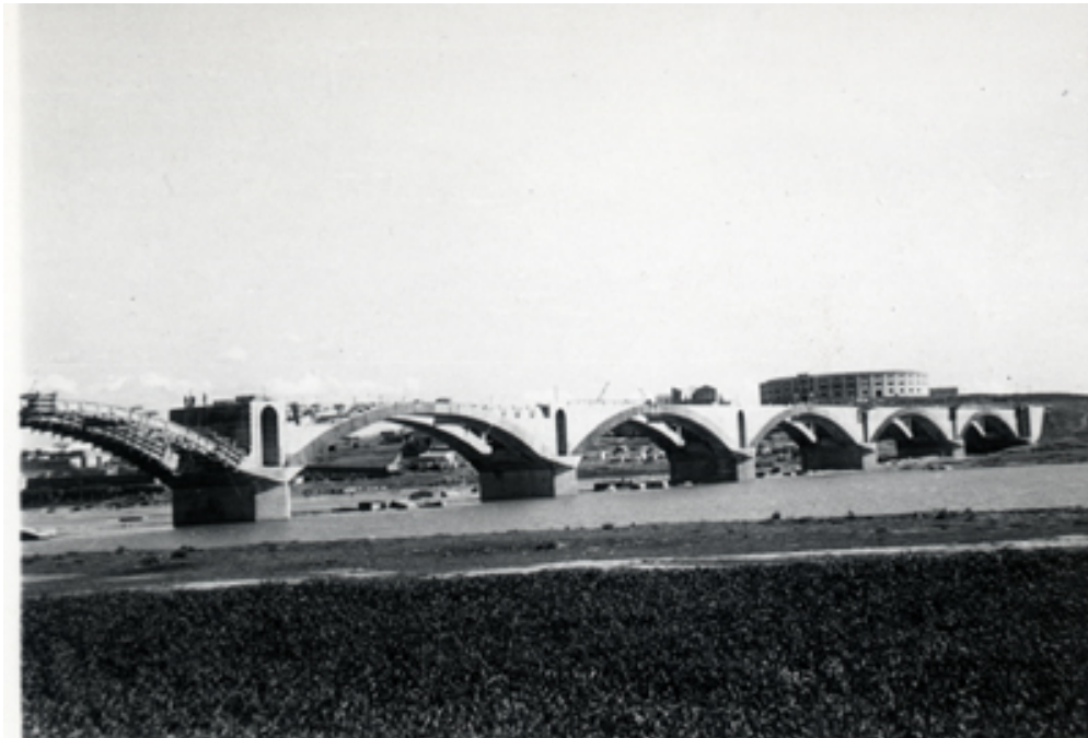
Vista del puente en construcción
