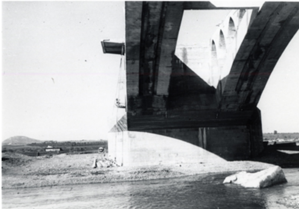
Detalle del puente en construcción
