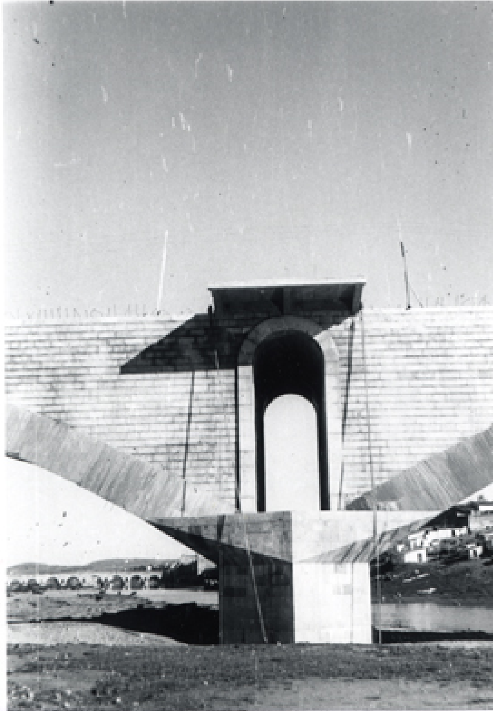
Detalle del puente en construcción
