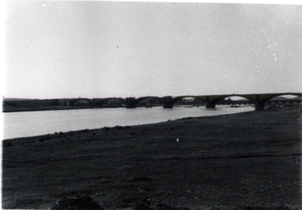
Vista del puente
