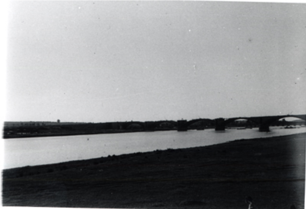
Vista del puente
