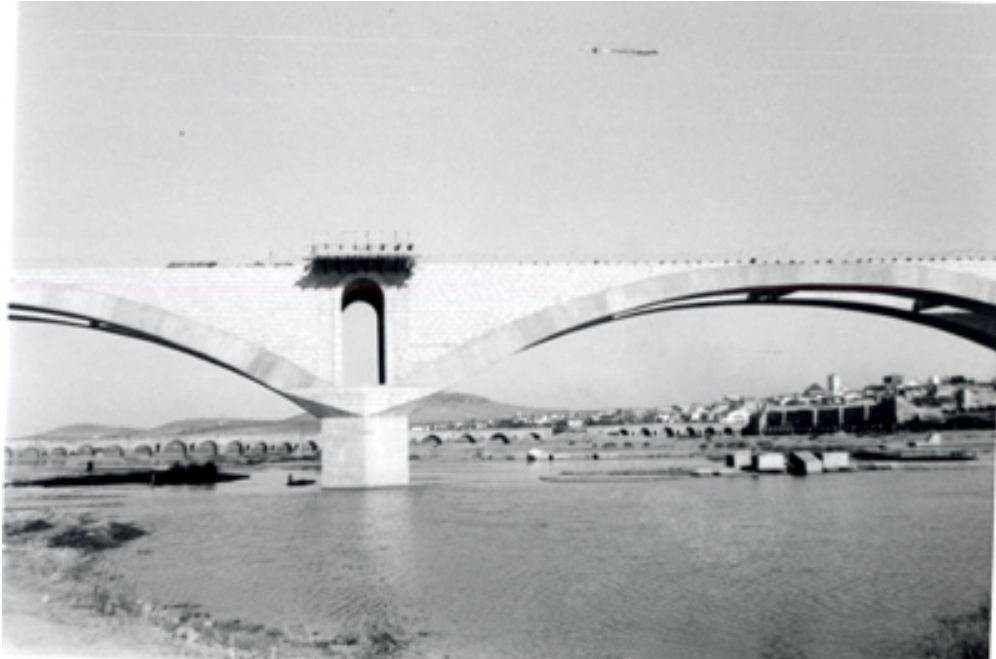
Detalle del puente en construcción
