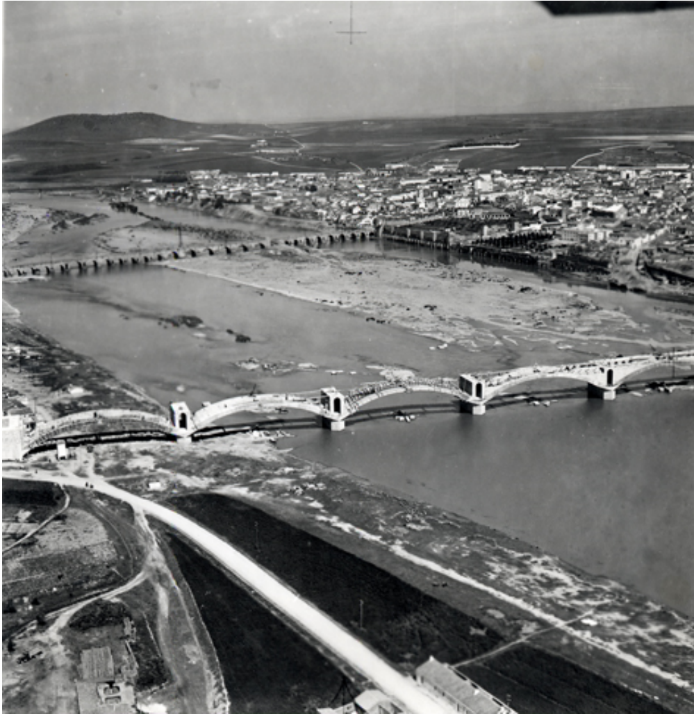
Vista aérea del puente en construcción
