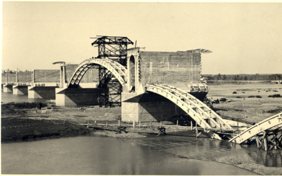
Detalle del puente en construcción
