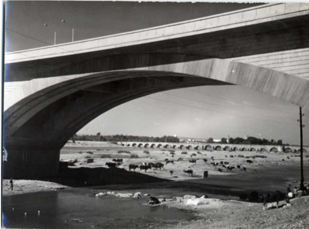
Detalle del puente
