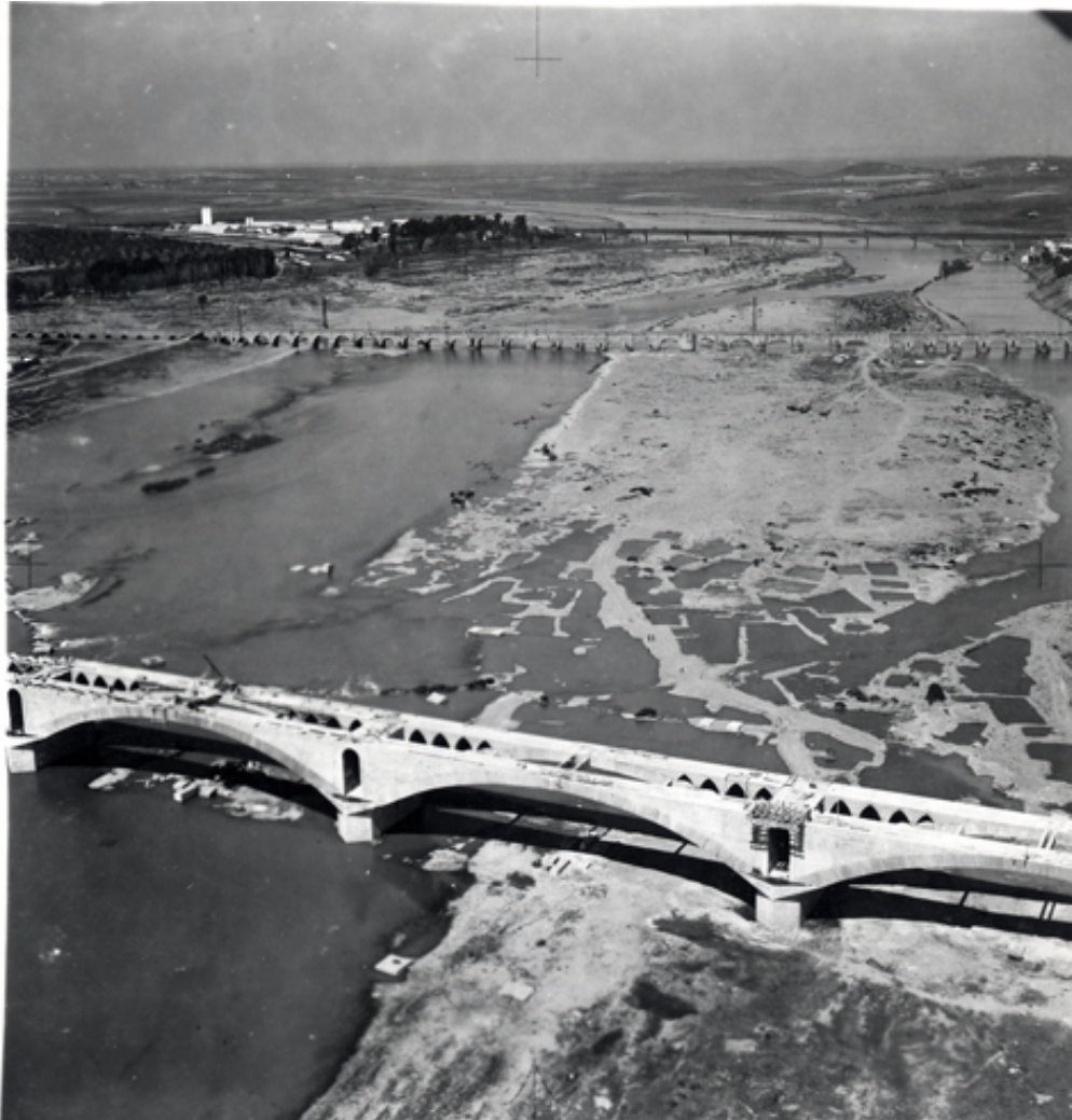
Vista aérea del puente en construcción
