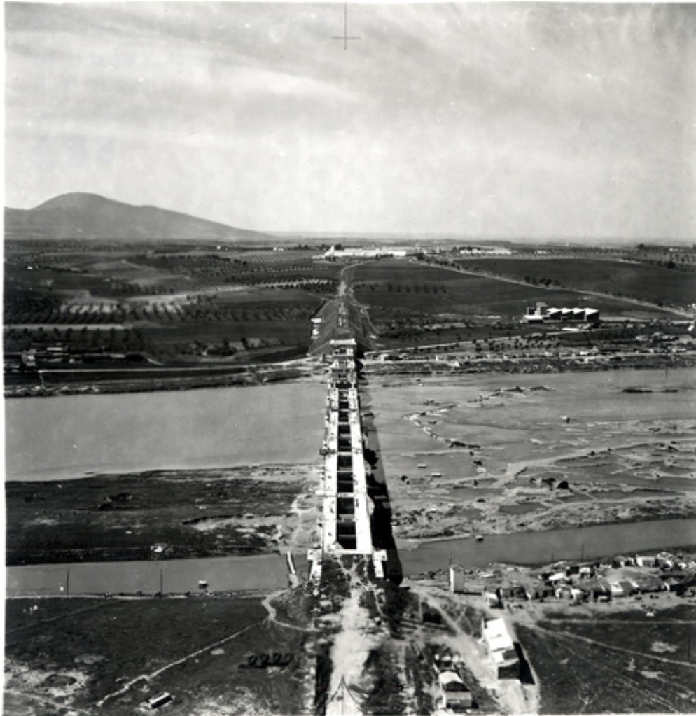
Vista aérea del puente en construcción
