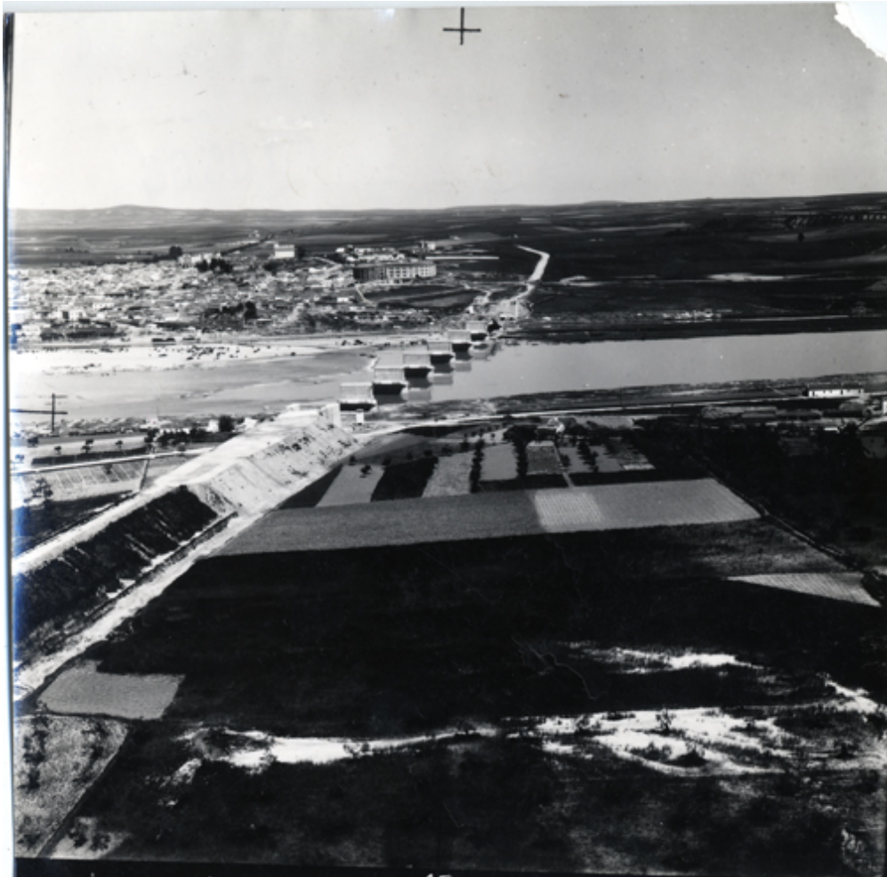
Vista aérea del puente en construcción
