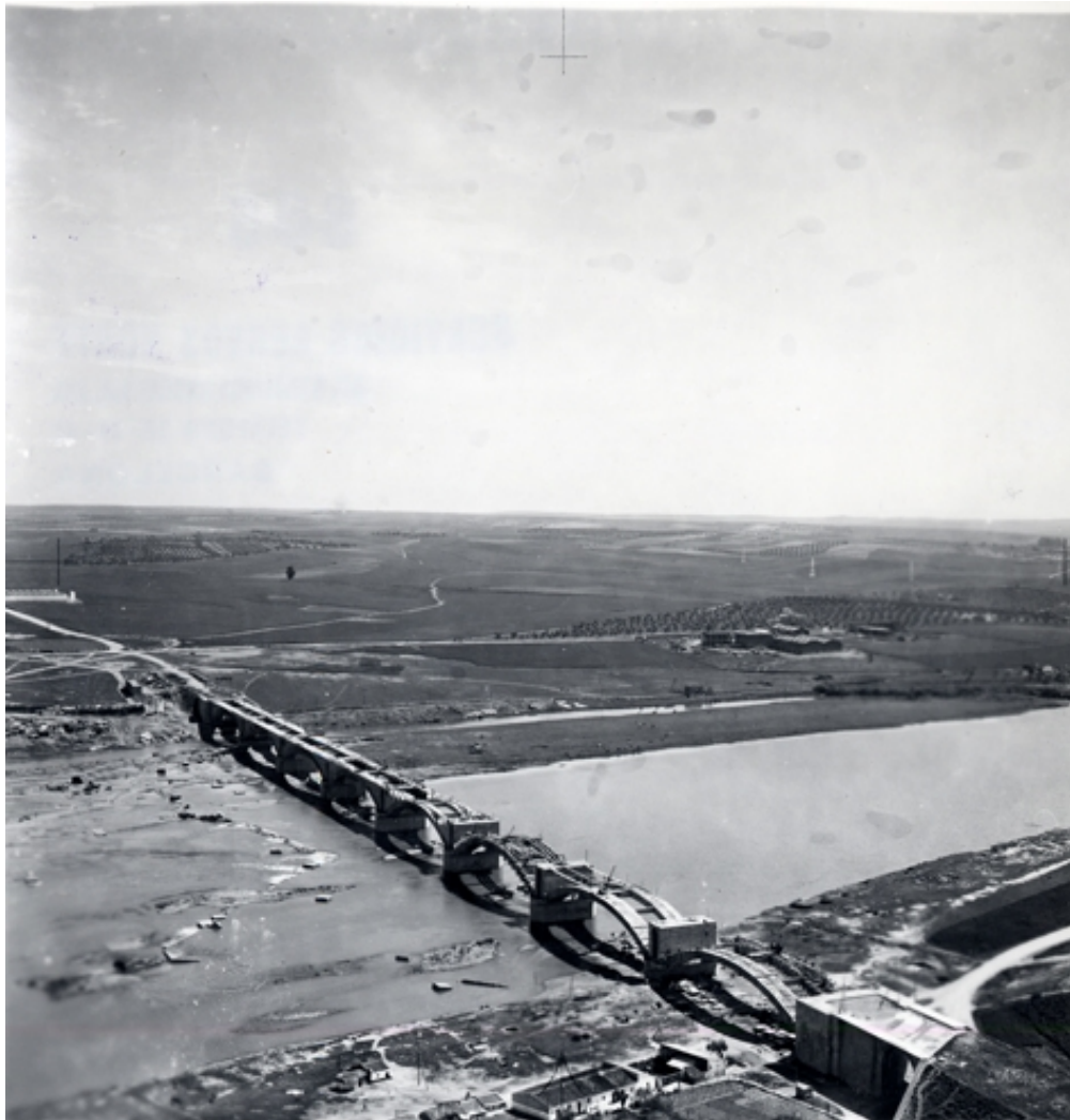
Vista aérea del puente en construcción
