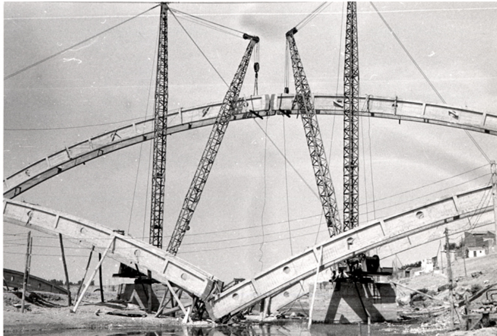
Detalle del puente en construcción
