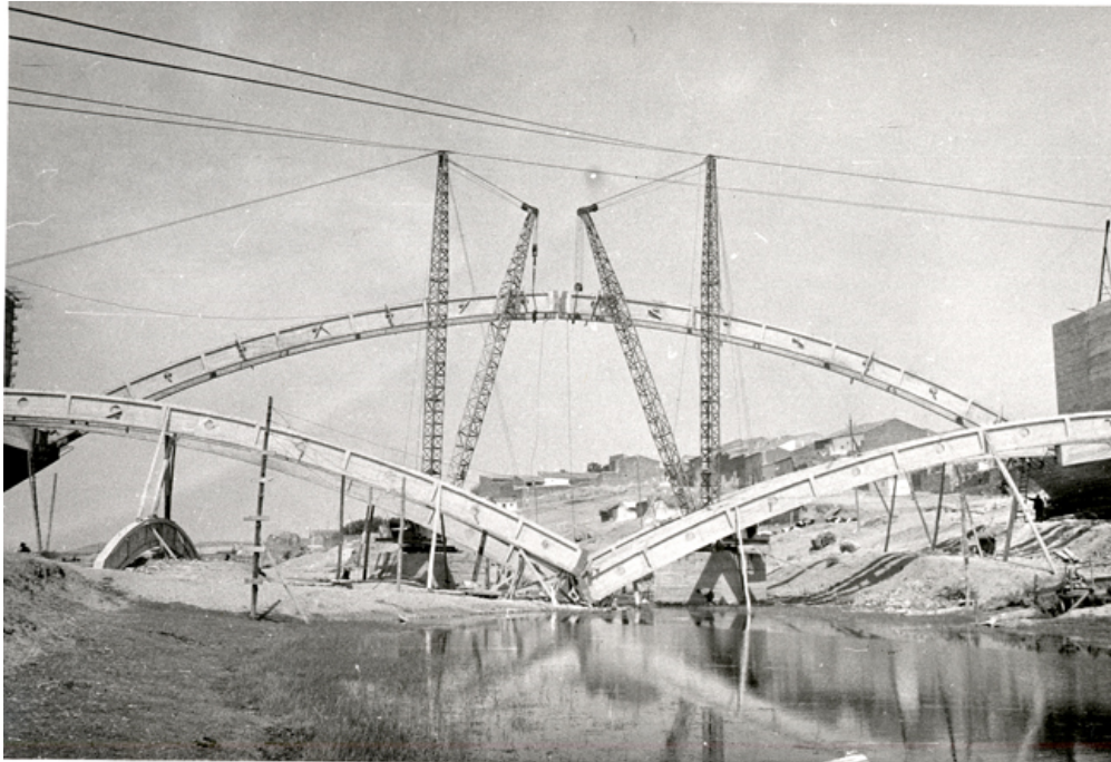
Detalle del puente en construcción
