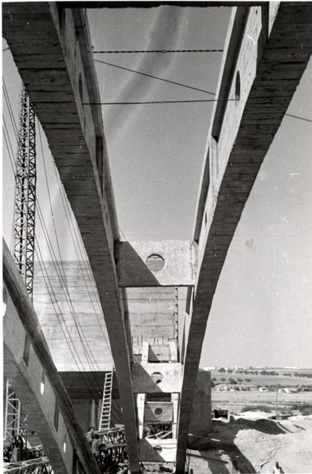
Detalle del puente en construcción
