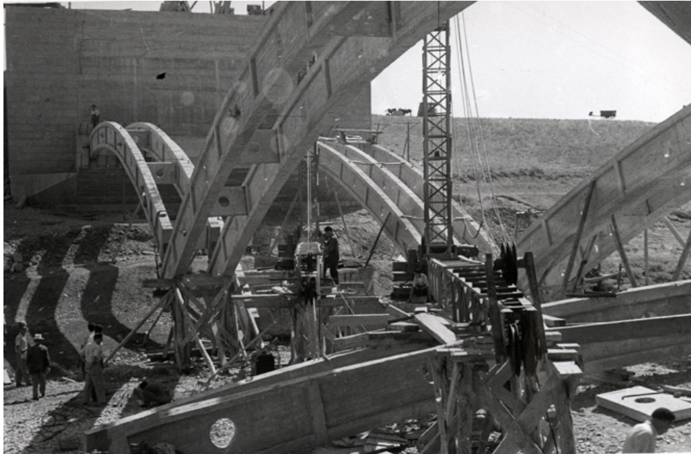
Detalle del puente en construcción
