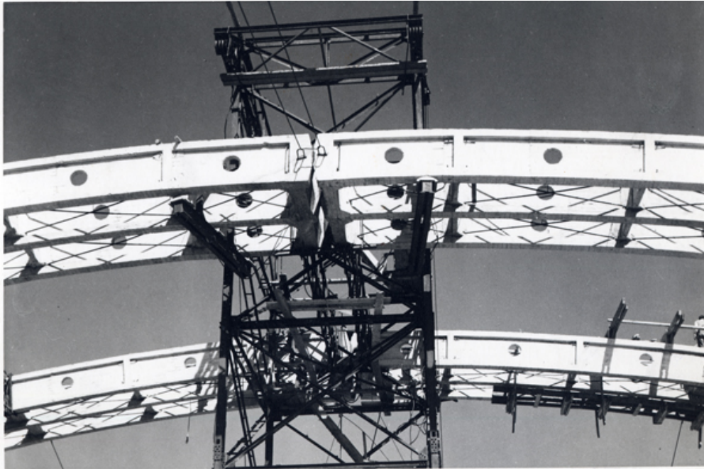
Detalle del puente en construcción
