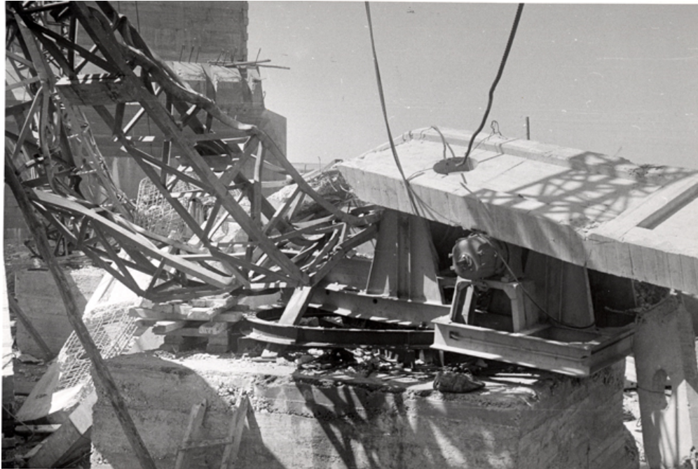
Detalle del puente en construcción
