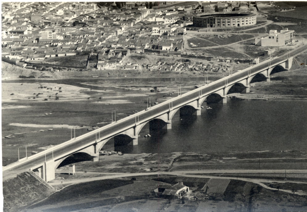
Vista aérea del puente
