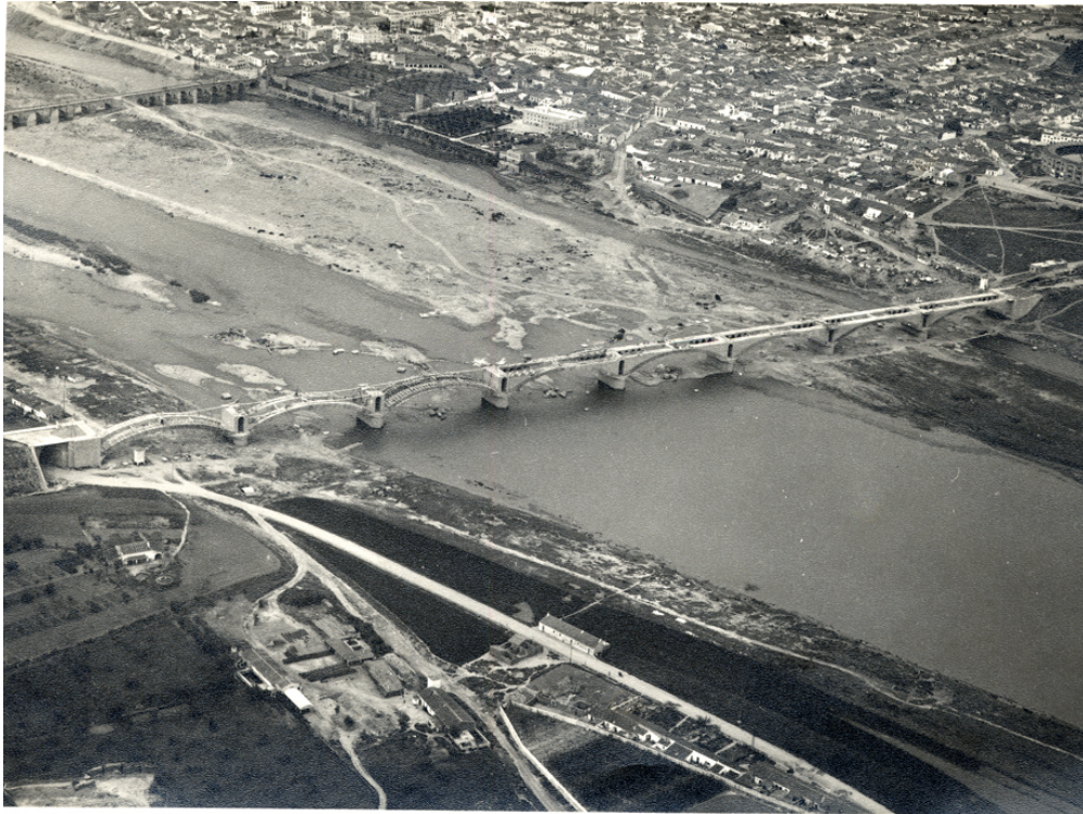
Vista aérea del puente en construcción
