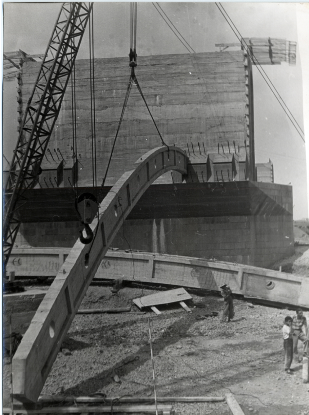
Detalle del puente en construcción
